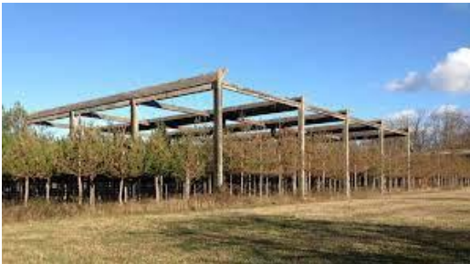
Sainte Livrade : un des bâtiments inachevés
