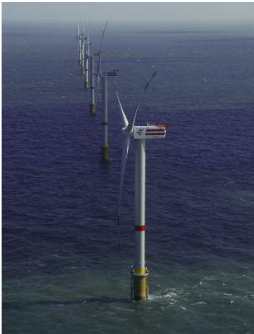
Eoliennes sur le banc Thornton en Mer du Nord près de la Belgique, 5 MW par turbine
