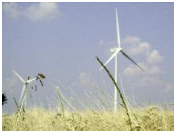
Gery (département de la Meuse), Eoliennes 10 MW
