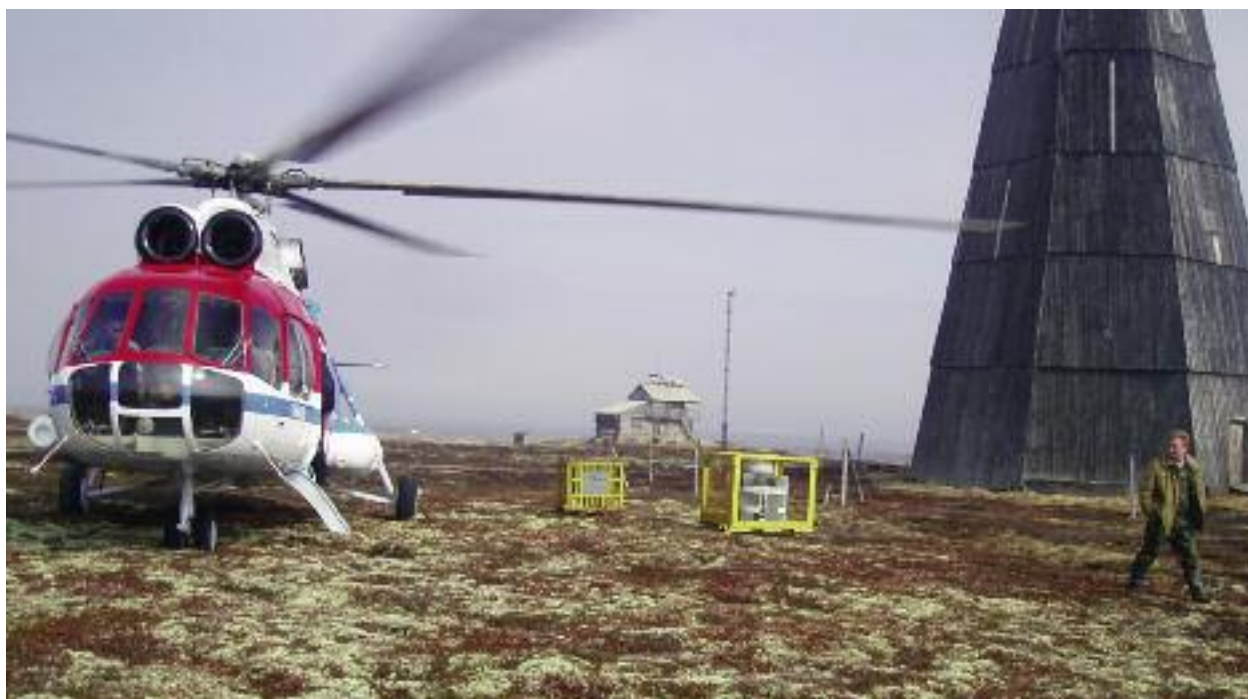
Enlèvement d'un RTG par hélicoptère en mer de Barents
