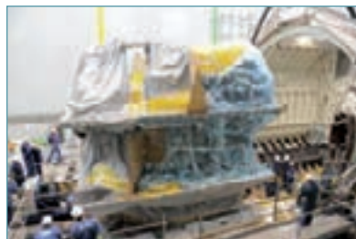
Embarquement du module chaufferie du Suffren en novembre 2012
