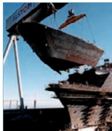
Pose de l'étrave
