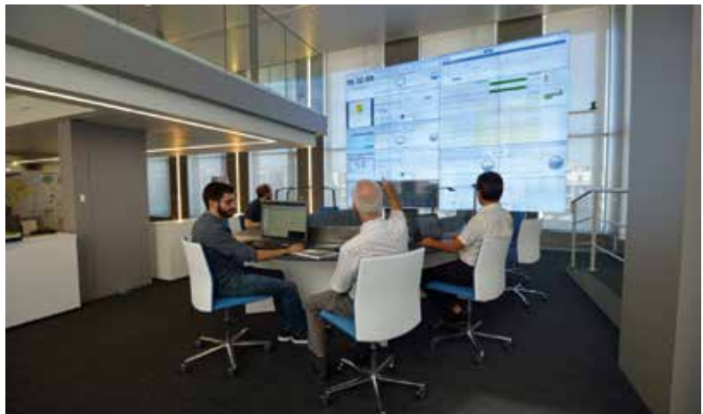
Le SERVO, nouveau centre de pilotage en temps réel du SEDIF également PC de crise
